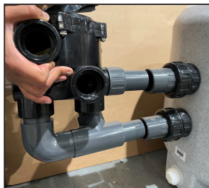
Diese Baugruppe bis zum Anschlag in die Filtereinsätze einfügen. DIESE VERBINDUNG WIRD SPÄTER GEKLEBT.
