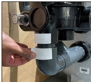
Zwei Stücke Abdeckband mit den Verbindungsstellen von Mehrwegeventil auslass und Anschlussrohr bündig aufkleben.
