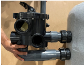
Verrohrung zuerst "trocken" zusammenbauen.
