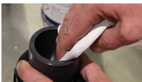
Rohr zuerst reinigen
