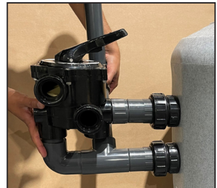
Kleber härten lassen. Der Filter sollte nun so aussehen.
