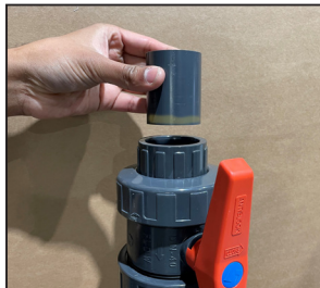
Den 6 cm Rohreinsatz nehmen. An einem Ende das Rohr außen und den Kugelhahn innen säubern und mit Kleber bestreichen, dann zusammenschieben.
