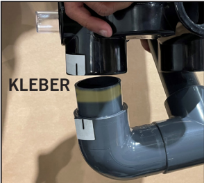
MPV-Auslass innen und das Anschlussrohr am Krümmer außen säubern und mit Kleber bestreichen, dann zusammenschieben. Sicherstellen, dass die Striche auf dem Abdeckband übereinstimmen.
