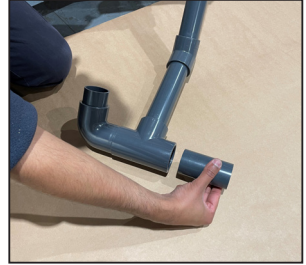
Das andere 9 cm Rohr in das T-Stück an der Verrohrung einschieben. DIESE VERBINDUNG WIRD SPÄTER GEKLEBT.
