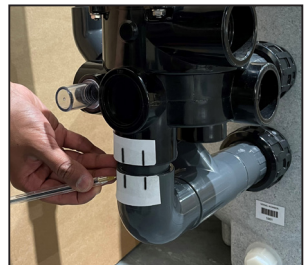
Drei senkrechte Striche über die beiden Abdeckbandstücke ziehen. Beim Kleben der Verbindung dann sicherstellen, dass diese Striche übereinstimmen.
